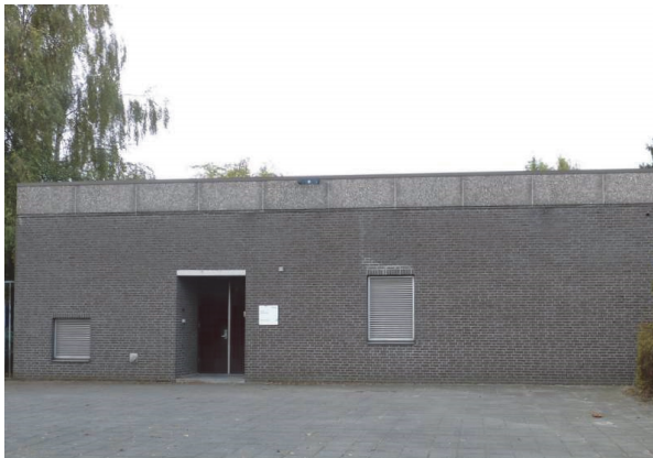
Figuur 7. Zuidzijde van het KPN-gebouw, met bestrating ervoor. In deze muur zitten open stootvoegen, geschikt voor vleermuizen. Foto genomen in noordelijke richting.
