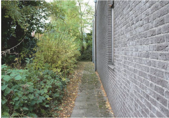
Figuur 5: Zijpad langs het KPN-gebouw aan de westkant. Foto genomen in noordelijke richting.
