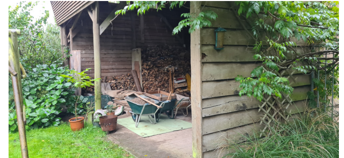
Figuur 11: Overkapping met opslag.
