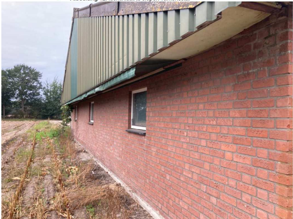
• Afbeelding 12: luchtinlaat te slopen varkensstal
