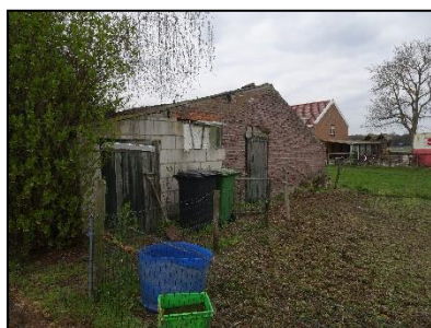
Figuur 3. Voormalige varkensschuur aan noordkant onderzoekslocatie.
