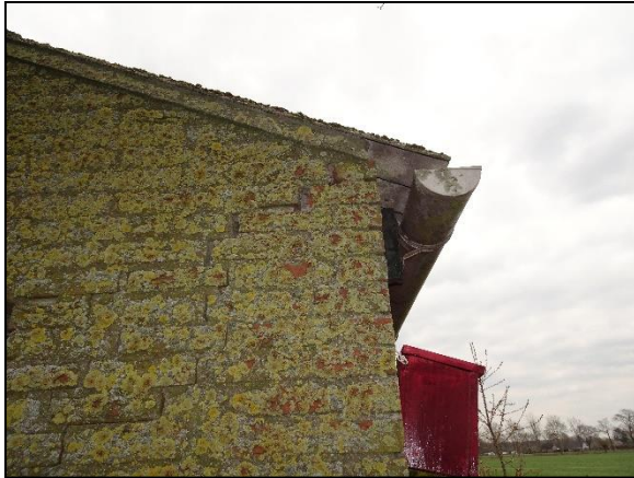
Figuur 9. Dakgoot van de garage die toegang kan verlenen voor de huismus onder het golfplaten dak.
