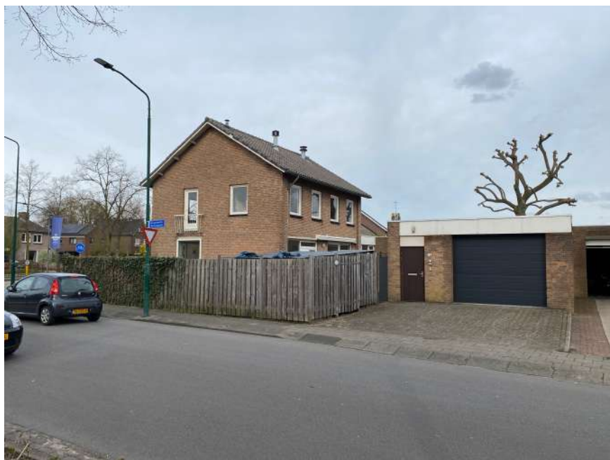
Planlocatie gezien vanaf het zuiden/Burgemeester Woltersstraat
