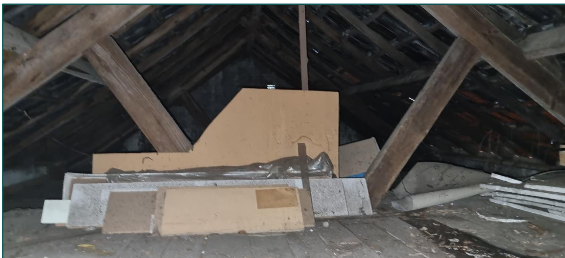
Figuur 2 De zolder van de schuur.
