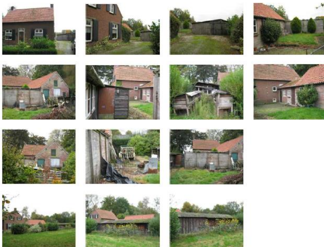
Afbeelding 4.2: foto's bestaande situatie
