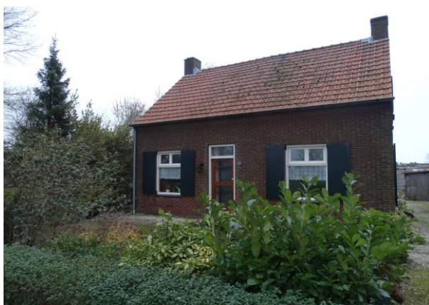
Figuur 3: Vooraanzicht te slopen woning
