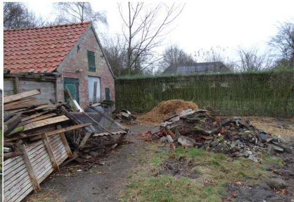
Figuur 6: Achterzijde aanbouw woning
