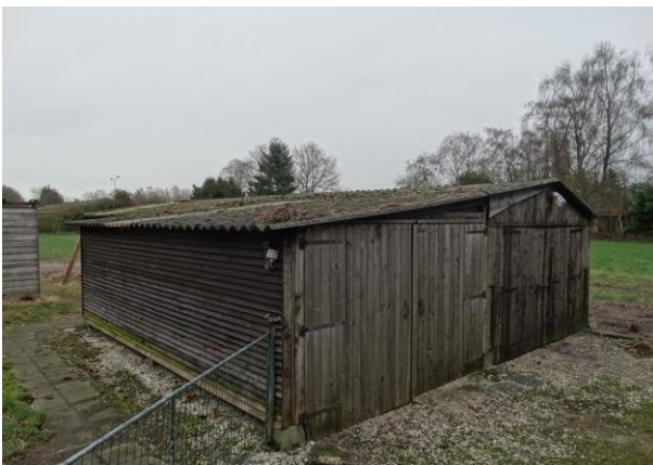
Figuur 7: Het te slopen schuurtje
