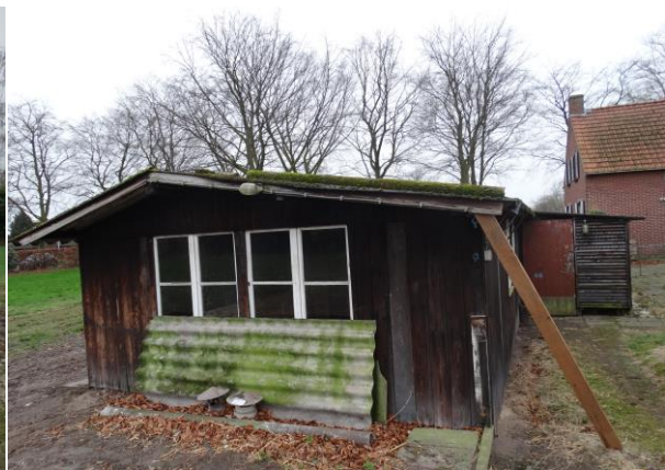
Figuur 8: Achterzijde het te slopen schuurtje
