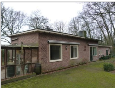
Figuur 6. Achterzijde van de woning op de onderzoekslocatie.
