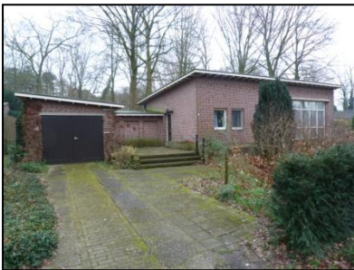
Figuur 3. Vooraanzicht van de woning op de onderzoekslocatie.
