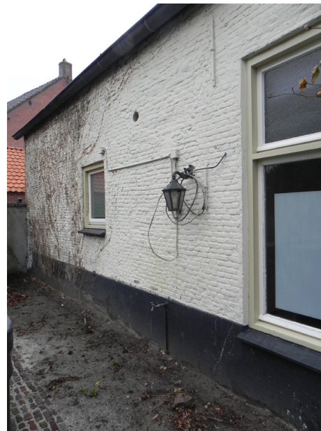
Het metselwerk van de stal vertoont twee soorten jonger metselwerk. Met een groter formaat steen is de gevel in het verleden integraal vervangen. Na de jaren '60 zijn twee openingen verkleind en gedicht.
