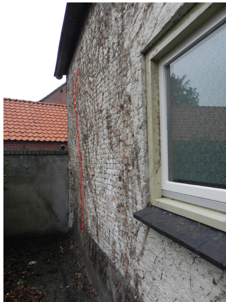
Aansluiting van 'nieuwere' en rechte zijgevel op de bolle oude achtergevel.
