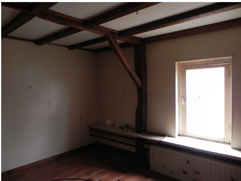
De afgeschoten kamertjes met muurstijlen tegen de kopgevel
