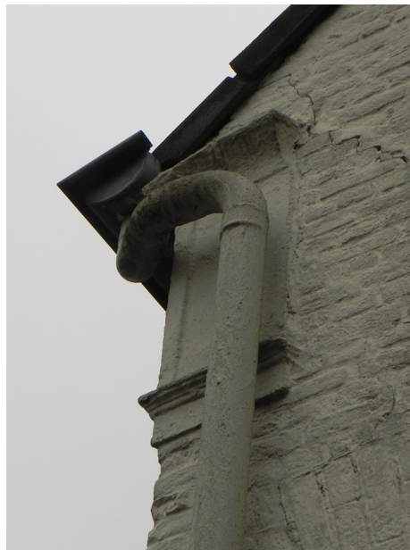
De bakgoot is vervangen door een mastgoot.
