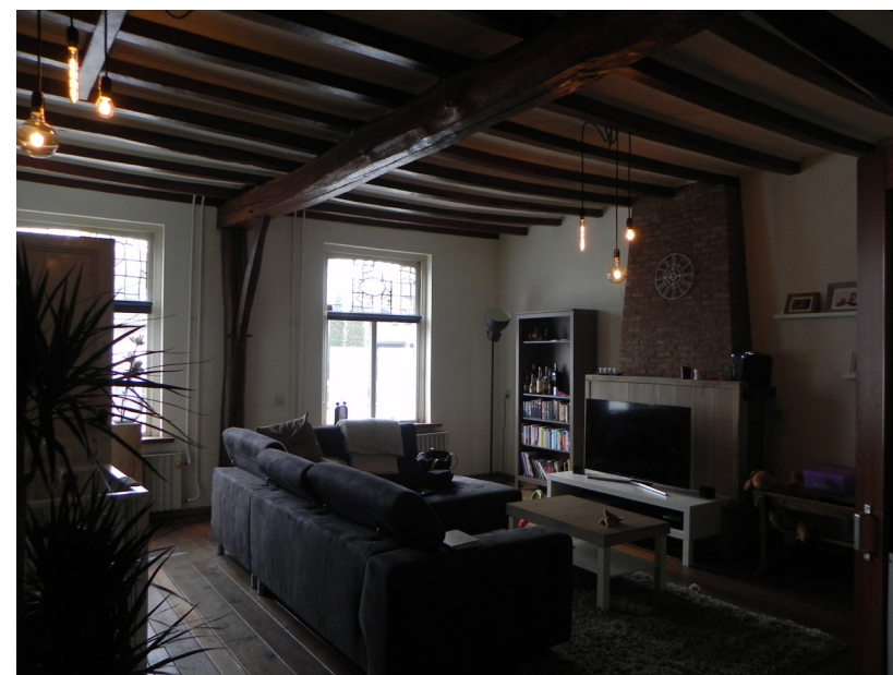
De kamers hebben nagenoeg allen oude eiken balklagen. De moerbalken hebben ter decoratie muurstijlen met schoren gekregen, deze zijn niet constructief.
