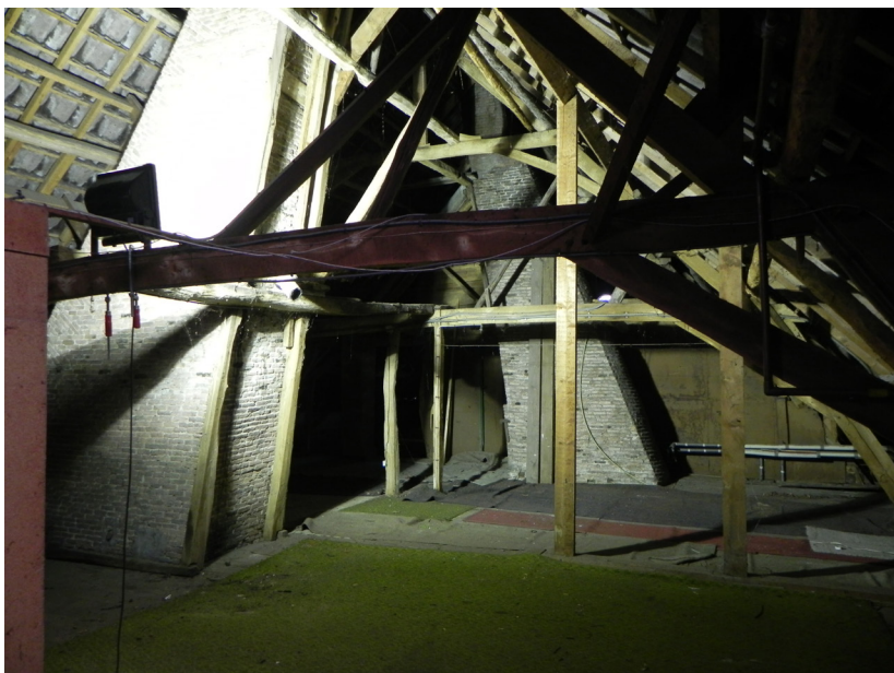
Open zolder met rookkanalen.
