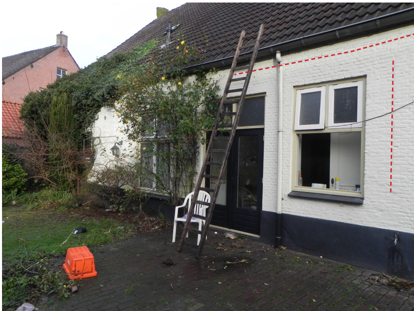
Achtergevel van het woongedeelte. Met rode lijnen zijn de bouwsporen zichtbaar gemaakt.
