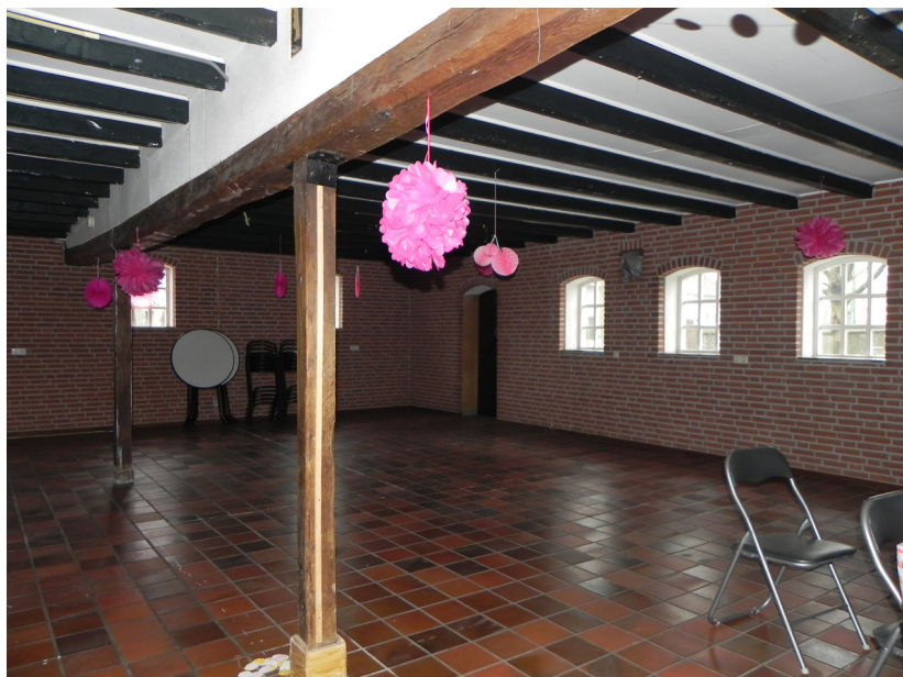
De oude moerbalk wordt door twee eiken stijlen ondersteunt.
