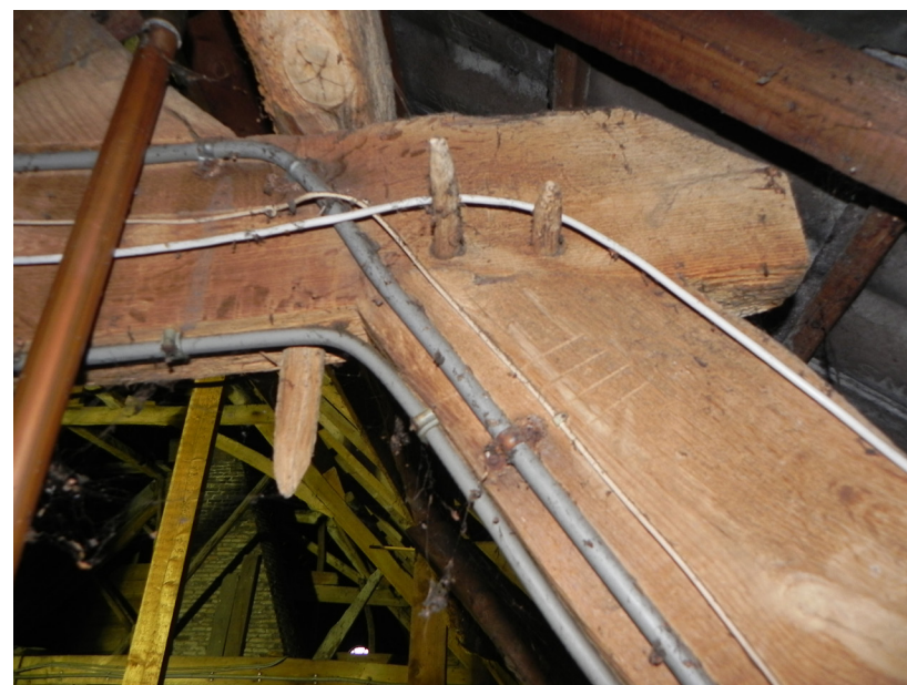
Detail van dekbalkjuk met telmerk IIII.
