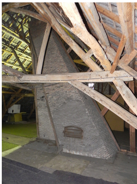
Het tegen een ouder rookkanaal aangemetseld derde rookkanaal
