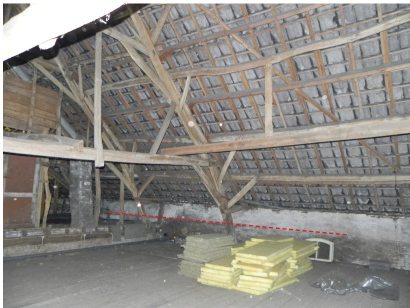
Spantconstructie op zolder boven stal. De stippellijn geeft de oude muurhoogte aan.
