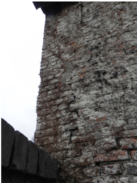
Aansluiting van 'nieuwere' en rechte zijgevel op de bolle oude achtergevel.
