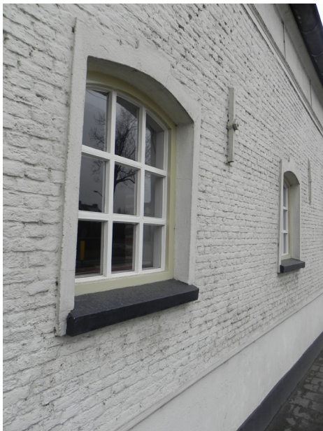
Houten stalramen ter vervanging van ijzeren.
