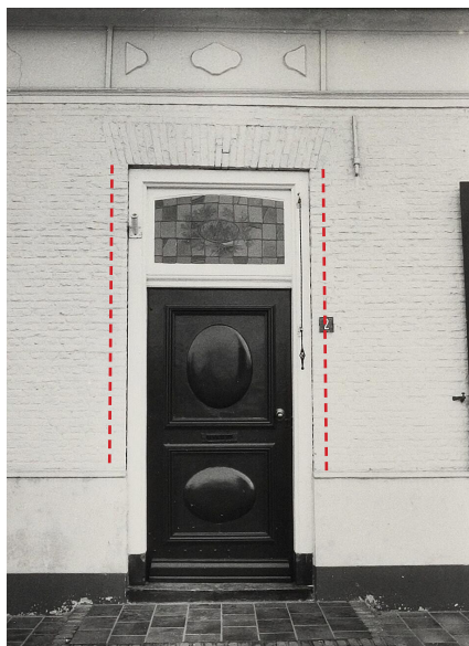
Voordeur in 1983. De rode lijnen geven de oorspronkelijke breedte van de muuropening aan. BHIC
