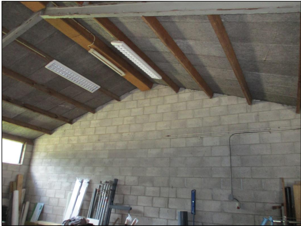
Figuur 3 De binnenzijde van de opslaggarage.
