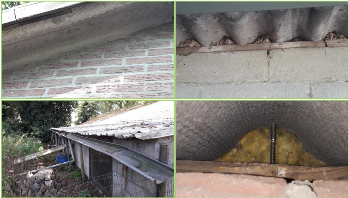
Figuur 2 Detailfoto's van de te slopen schuur
