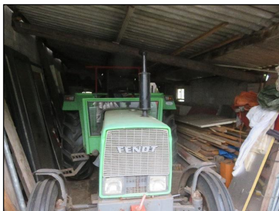
Foto 4. Binnenkant van gebouw 1
