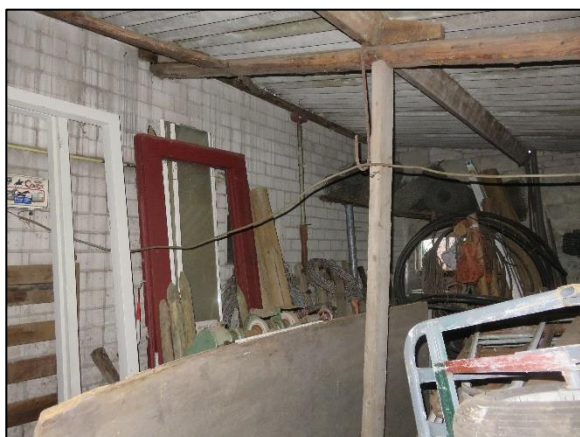
Foto 3. Binnenkant van gebouw 1
