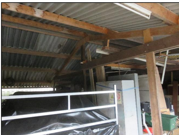
Foto 7. Binnenkant van overkapping gebouw 2
