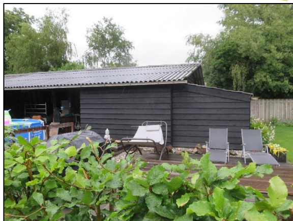
Foto 6. Zuidelijke deel van gebouw 2
