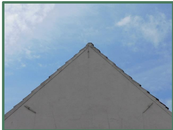
Afgesloten zijgevel pannendak
