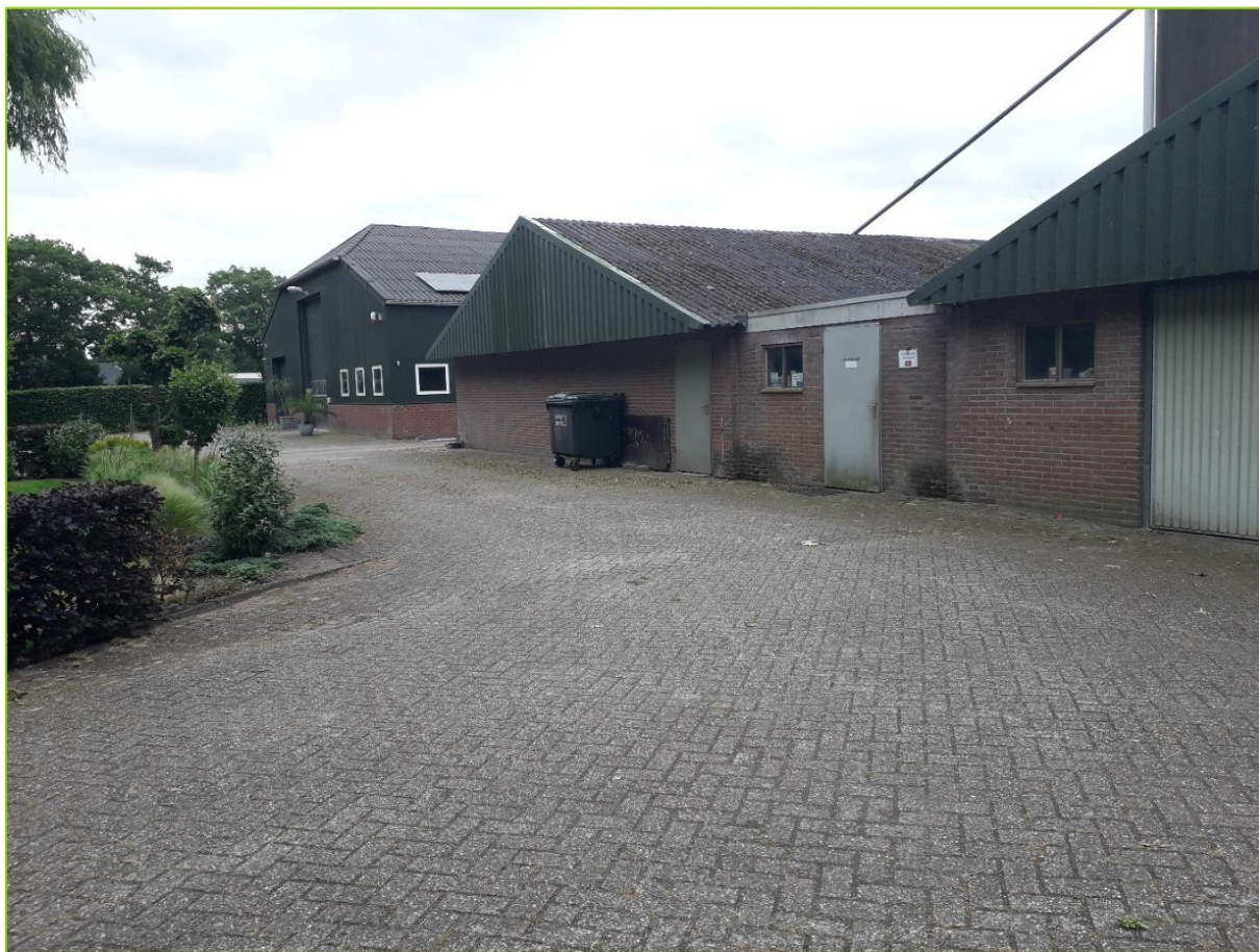
De stallen zijn opgetrokken uit gemetselde gevels en voorzien van een golfplaten dak.
