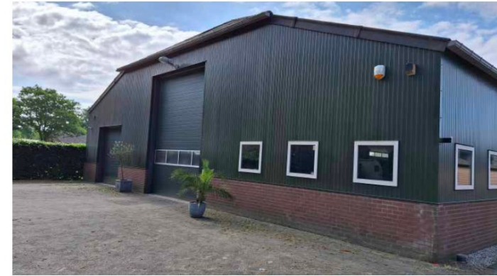
Figuur 16. Bestaande loods
