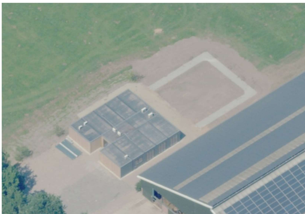
• Afbeelding 15: Luchtfoto zijaanzicht tijdelijk kinderdagverblijf met de natuurspeelplaats in aanbouw
