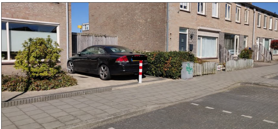
Figuur 5 Opritconstructie en parkeren op privégrond in de Verdilaan (Deelgebied X)
