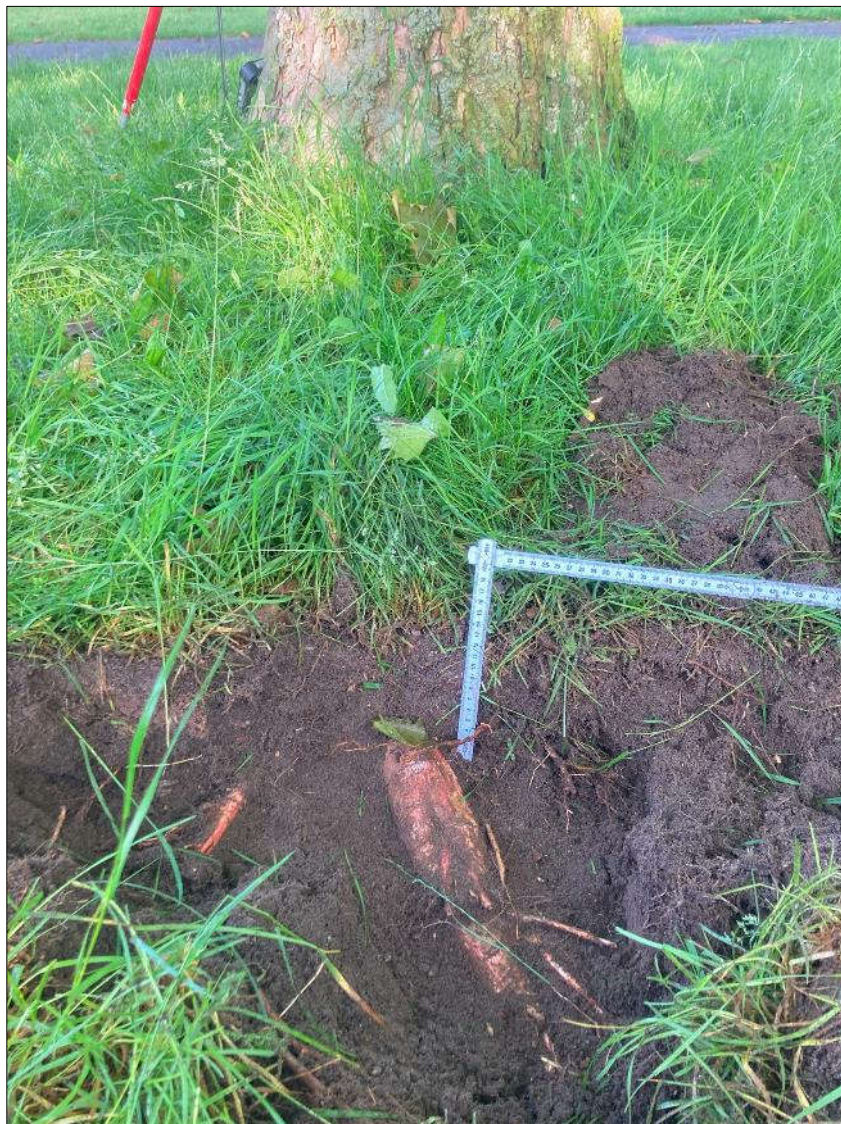
Afbeelding 14: Op 15 cm-mv zijn 2 wortels aangetroffen (diameter 4 en 8 cm)
