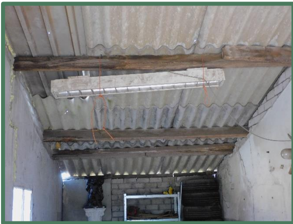
Binnenzijde te slopen schuur
