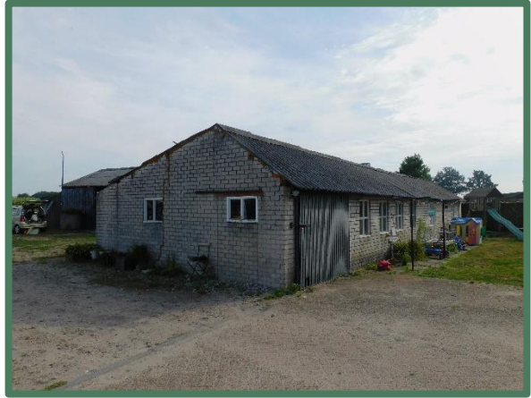
Voorzijde te slopen schuur
