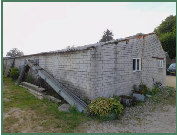
Achterzijde te slopen schuur
