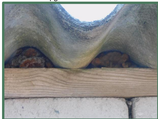
Opgevulde golven met bouwschuim
