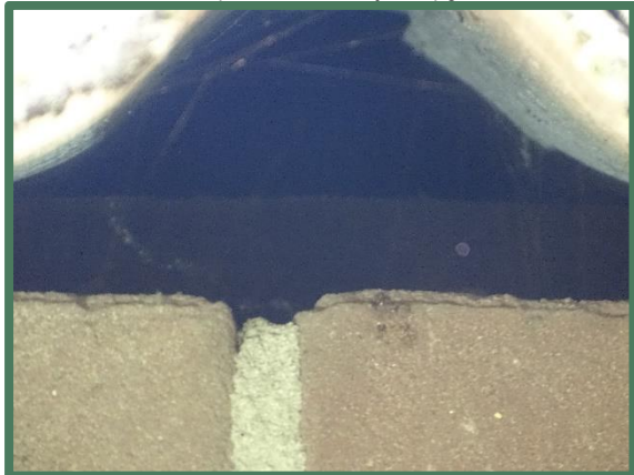
Foto 23: Wand stal aan bovenzijde voorzien van houten lat
