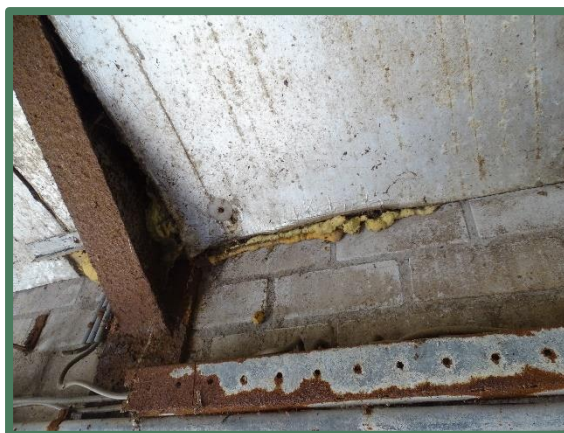
Foto 26: Dakbeschoot stal voorzien van bouwschuim
