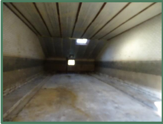
Foto 13: Binnenzijde voormalige vleeskalverenstal
