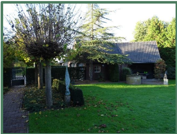
Foto 5: Garage/tuinhuis vanaf het oosten
