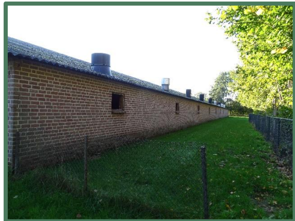
Foto 10: Noordelijke wand stal, vanaf het noordoosten
