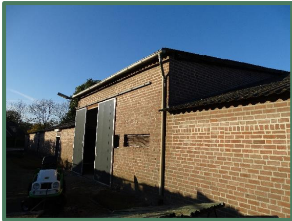
Foto 7: Zuidelijke wand stal, vanaf het oosten
