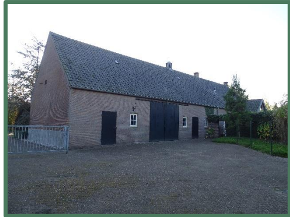
Foto 2: Woning vanaf het noorden
