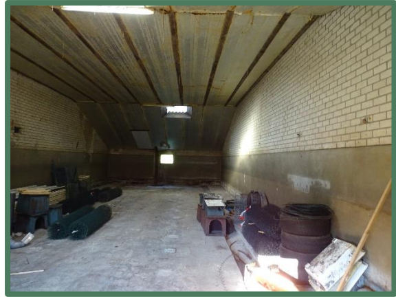
Foto 14: Binnenzijde voormalige vleeskalverenstal
