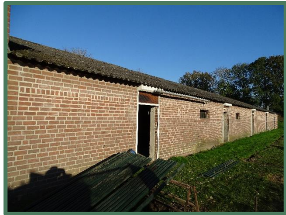
Foto 8: Zuidelijke wand stal, vanaf het westen
