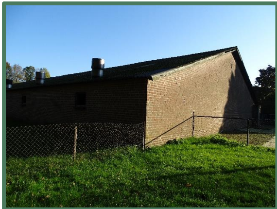
Foto 9: Westelijke kopgevel stal, vanaf het noordwesten
