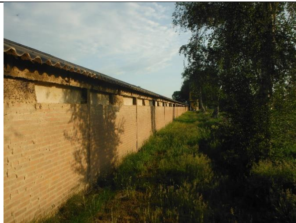
Vanuit zuidelijke richting nabij boring 8
