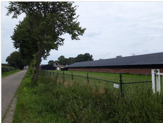
Afbeelding 7. Kippenstal aan de Bunderstraat.
