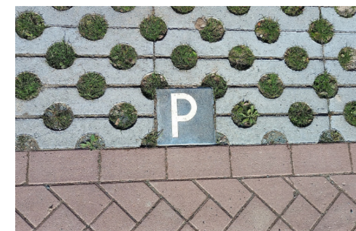
Parkeerstroken in halfverharding voor de doorwaterering
