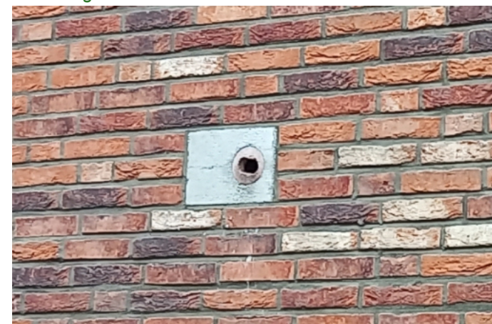
Nestkasten integreren in de muren voor zwaluwen (voorbeeld) of vleermuizen
