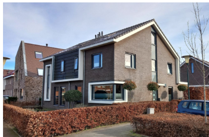
Eindwoning, meerzijdige oriëntatie, overstek, siermetselwerk en verlaagde goot (aansluiting buitengebied)
