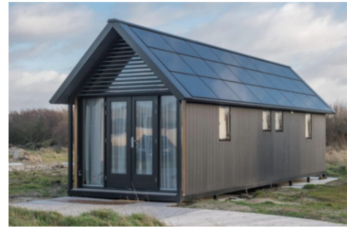
referentie: technische installaties integraal onderdeel van het ontwerp
