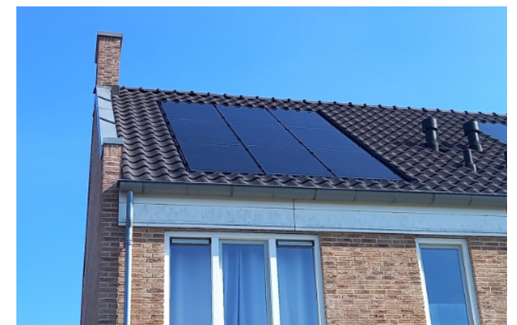
Voorbeeld van een dak waar de zonnepanelen zijn geïntegreerd in de dakbedekking
