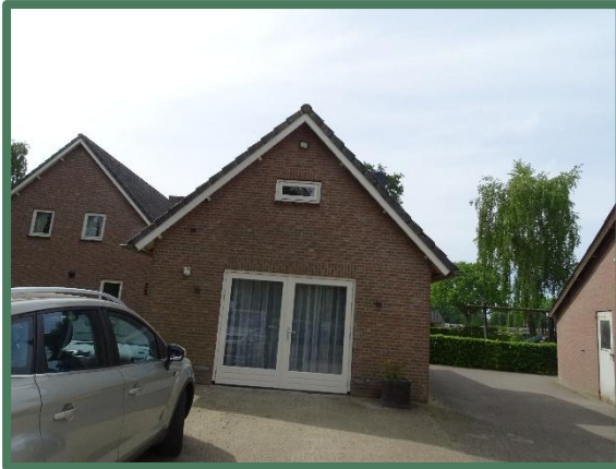
Foto 9: Noordgevel te behouden bedrijfswoning.
