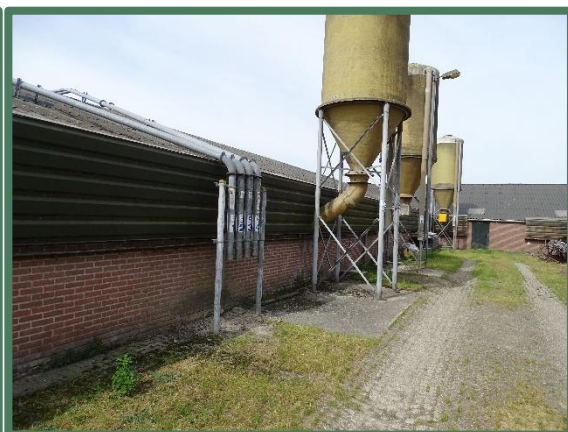
Foto 2: Noordgevel zuidelijke varkensstal met damwand en silo's.
