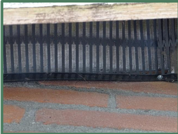
Foto 4: Vogelschroot achter overstek betimmering.
