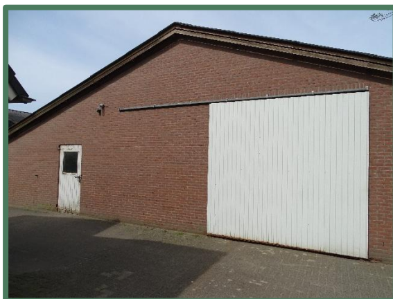
Foto 1: Oostgevel zuidelijke varkensstal.
