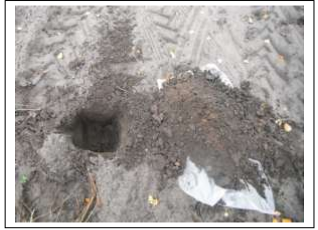
Foto 14. Asbestinspectiegat 14 met opgegraven materiaal
