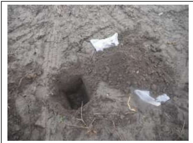
Foto 15. Asbestinspectiegat 15 met opgegraven materiaal
