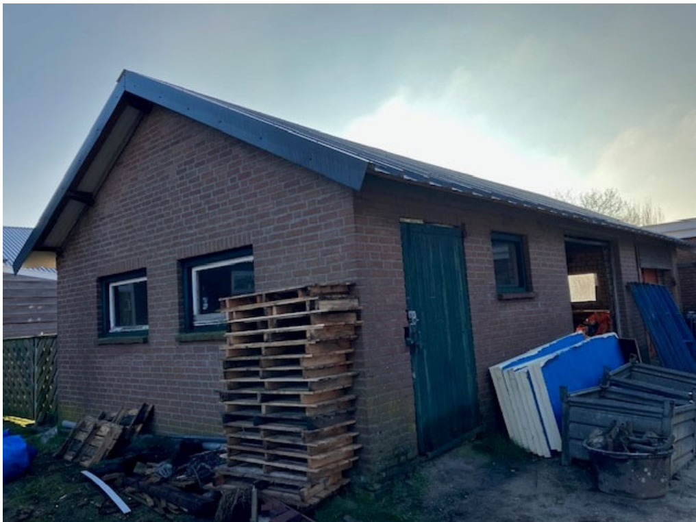
• Afbeelding 4: te slopen garage
