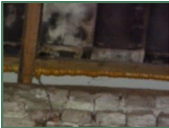
Panlatten en bouwschuim sluiten de eerste rij pannen af
