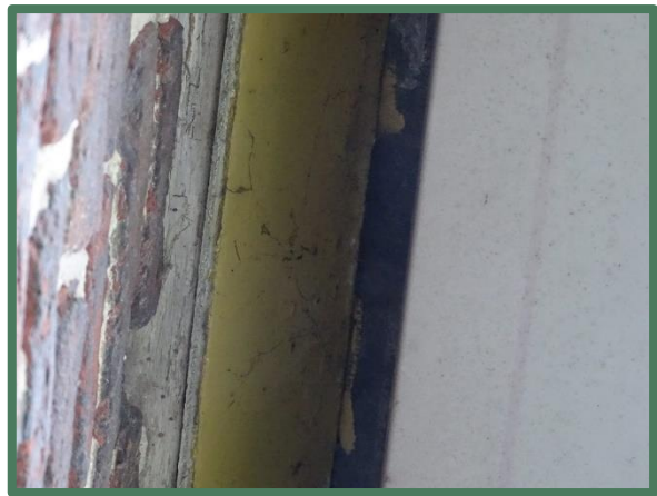
Gebrek aan ruimte tussen de wand en het dak
