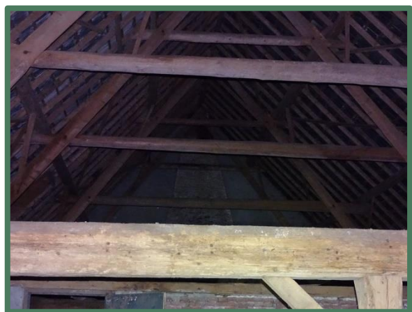
Overzicht onderzijde van het dak
