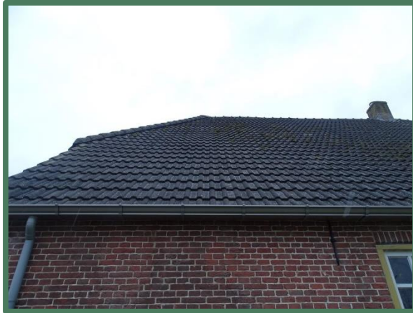
Overzicht te vervangen betonnen dakpannen
