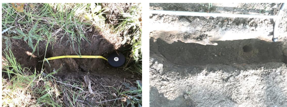
Figuur 8 Proefsleuf op locatie C (links) en proefsleuf op locatie D (rechts).
