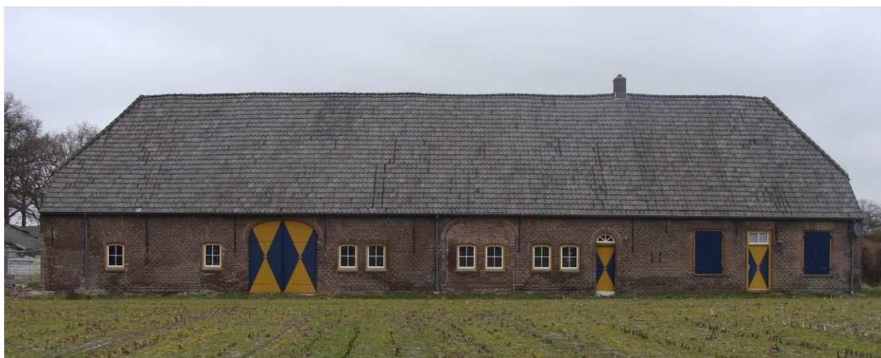
Figuur 16 – De voorgevel.
