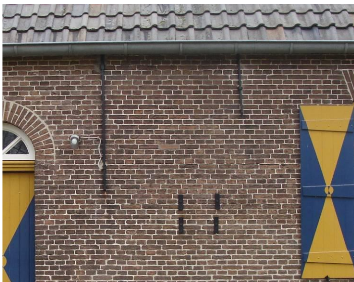
Figuur 26 – Een viertal ijzeren strippen, verbonden met de console van de melkmachine aan de binnenzijde.
