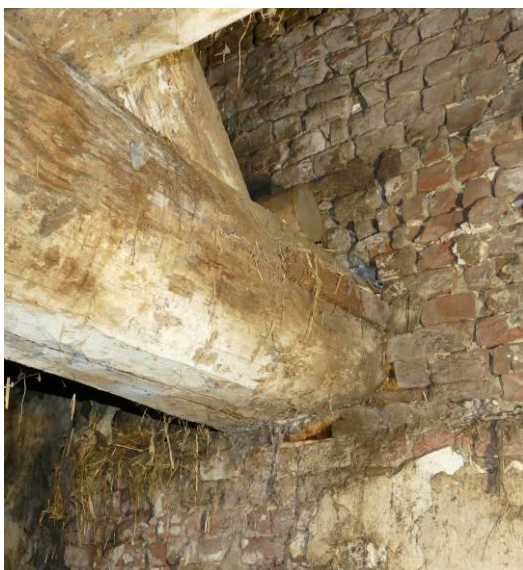
Figuur 25 – De korte veer van een muuranker, verbonden met een ligger.
