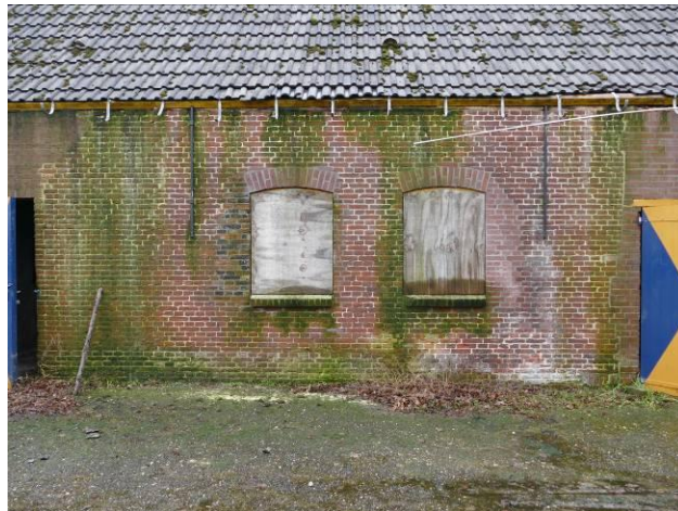
Figuur 36 – Het koppel stalramen van de schuur.
