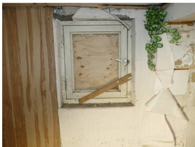
Figuur 50 - Detail van de opkamer met rechtsboven de moerbalk.
