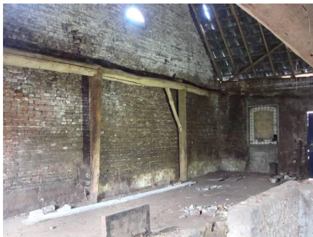
Figuur 63 – Een gedeelte van het gebint tegen de eindgevel.
