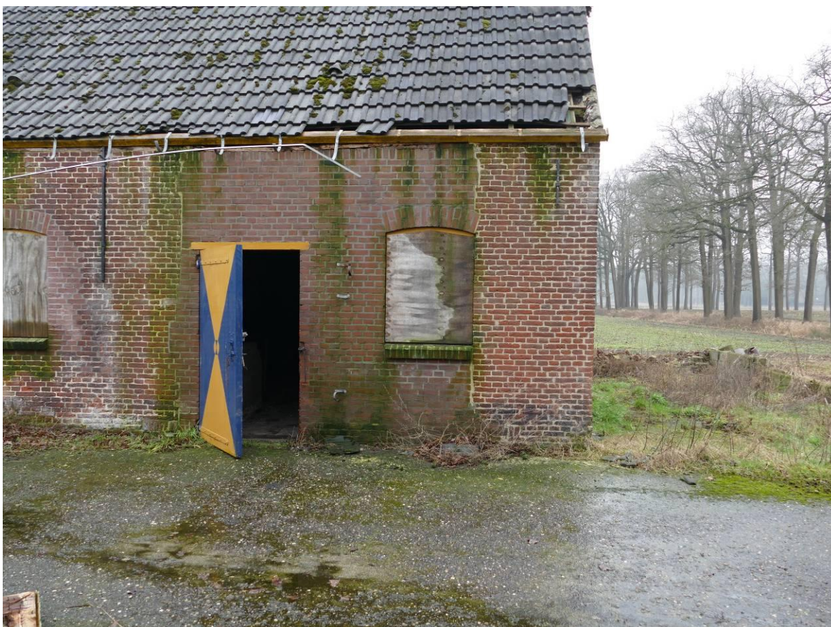
Figuur 37 – Loopdeur en raam op de plaats van de vroegere dubbele deeldeuren.
