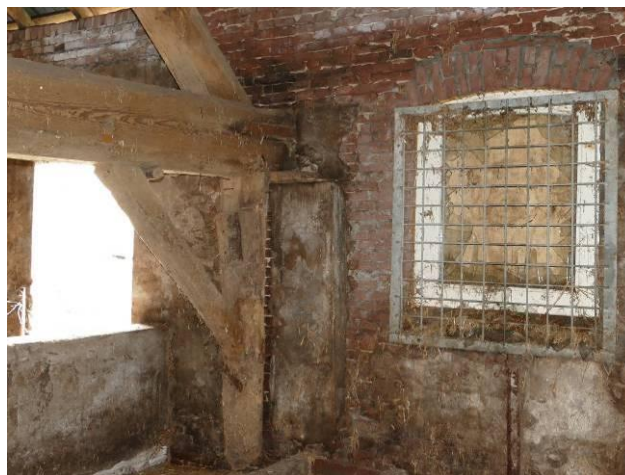
Figuur 64 – De eiken staander van het tweede gebint.
