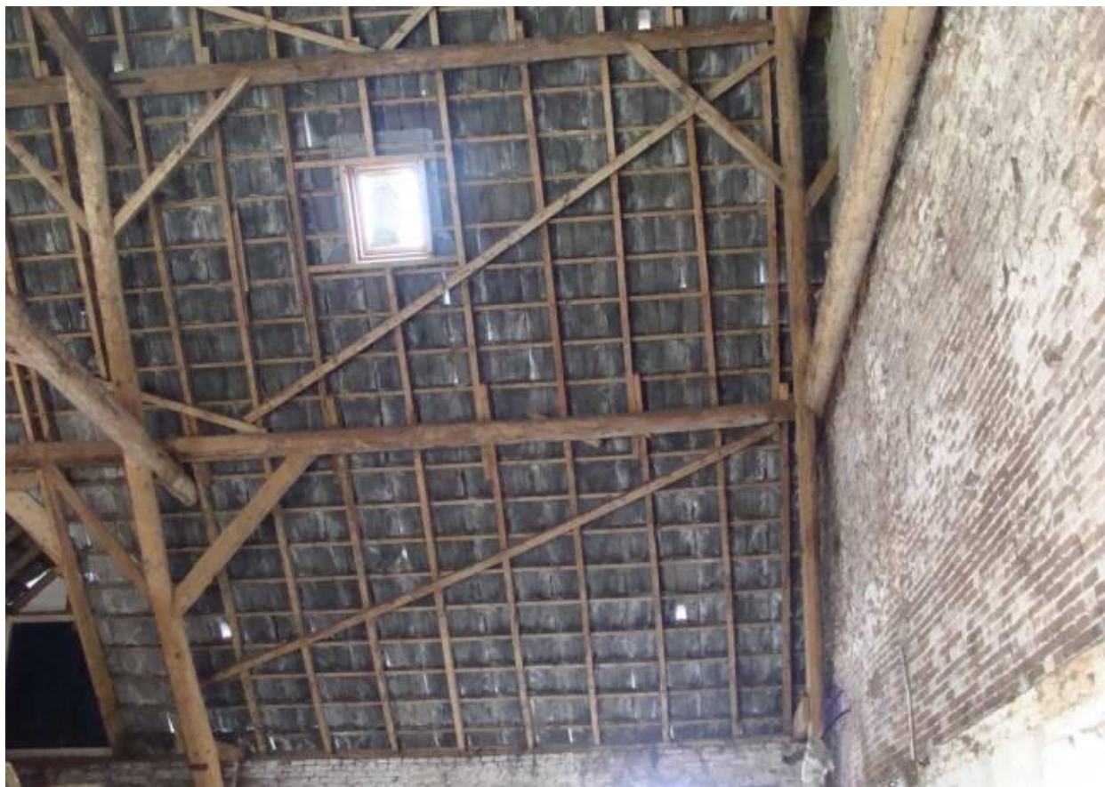
Figuur 65 - De driehoeksgewijze dwarsverbindingen in de kap.
