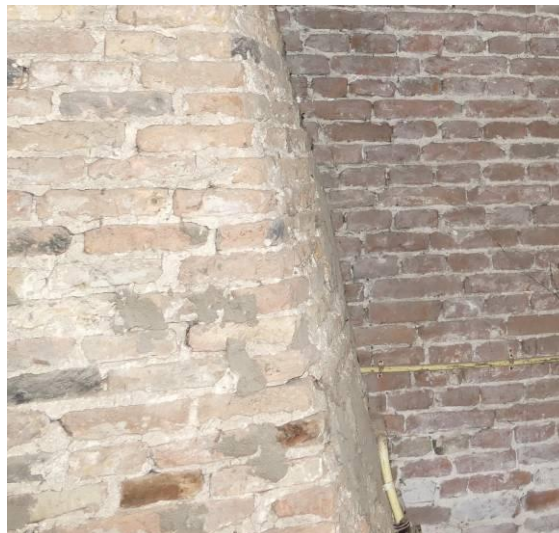
Figuur 4 – Detail van de schouw met daarop enkele bakstenen met brandsporen.
