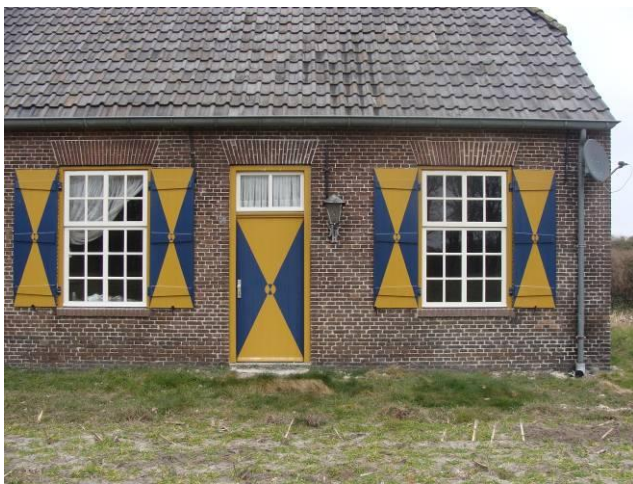
Figuur 21 – De voorgevel van het woongedeelte.
