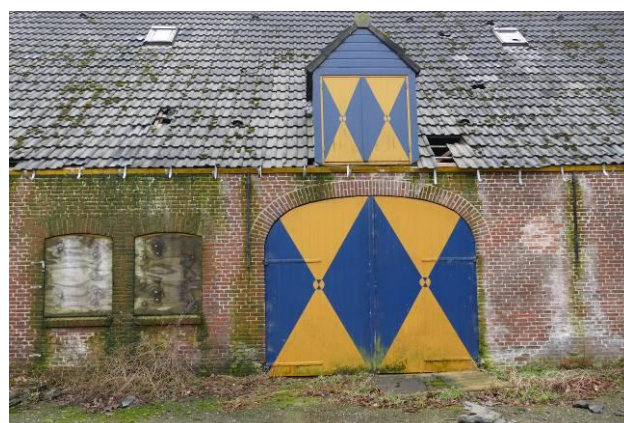
Figuur 34 – De dubbele mestdeur en het hooiluik.
