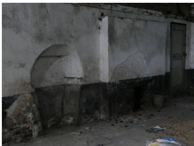
Figuur 57 – De nis in de brandgevel waarin zich de sopketel bevond.
