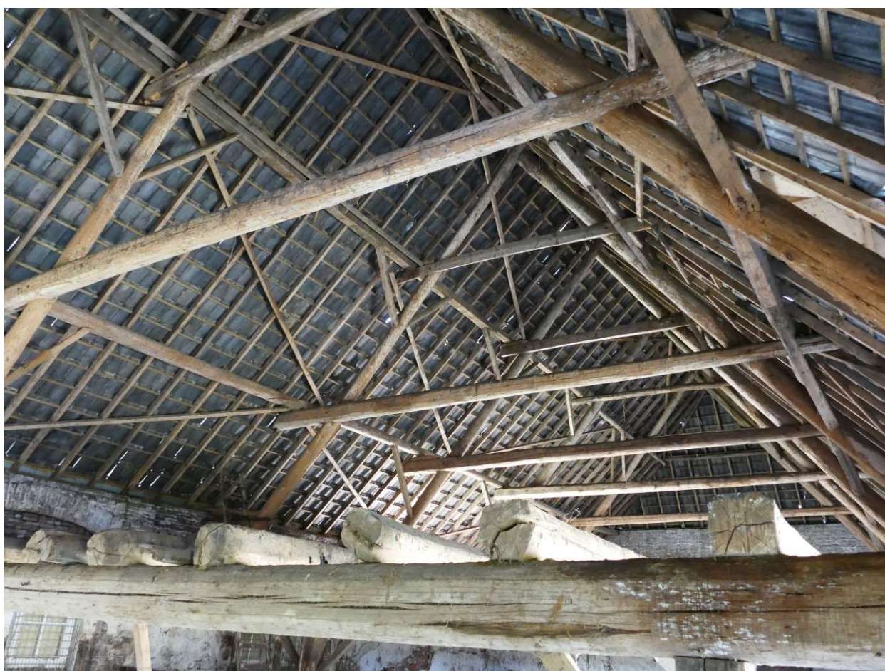
Figuur 56 – Kap van het bedrijfsgeboude met in de voorgrond een van de grenen liggers.
