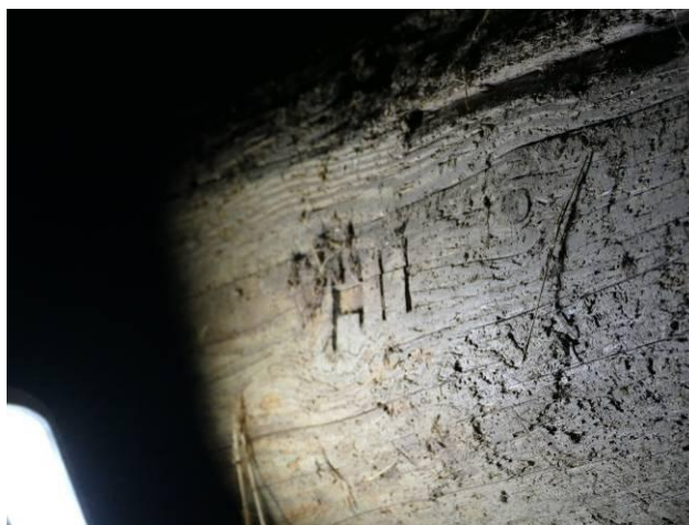
Figuur 62 – Voorbeeld van een van de aanwezige telmerken.
