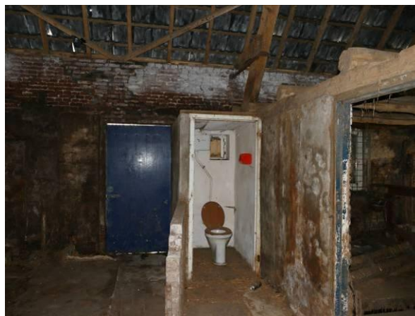
Figuur 12 – De wc in de verbouwde schuur.
