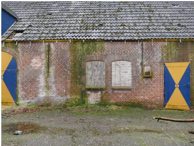
Figuur 35 – Het kleine wc raampje en de loopdeur van de schuur.
