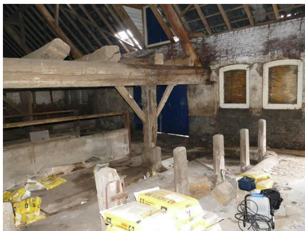
Figuur 61 – Een van de grenenhouten liggers met een standvink op een hoge poer.
