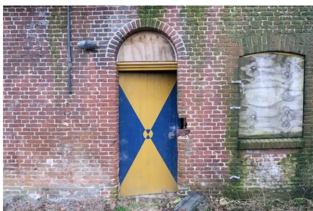
Figuur 33 – De deur naar de voorstal met de eenvoudigere cirkelvormige strek.
