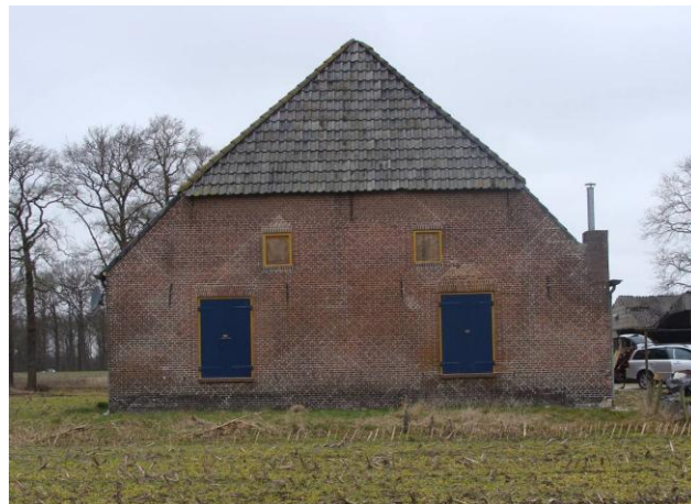
Figuur 28 – De kopgevel.
