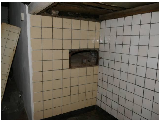
Figuur 43 – De opening naar de bakoven.
