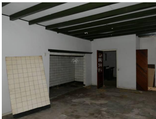
Figuur 10 – De vloer van de herd, met de restanten van het zeil op de oude plavuizen.
