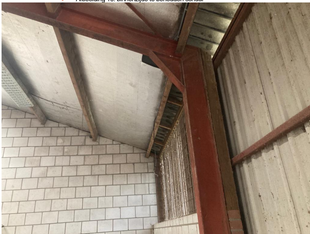
• Afbeelding 16: binnenzijde te behouden schuur
