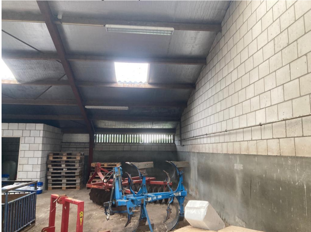
• Afbeelding 17: binnenzijde te behouden schuur
