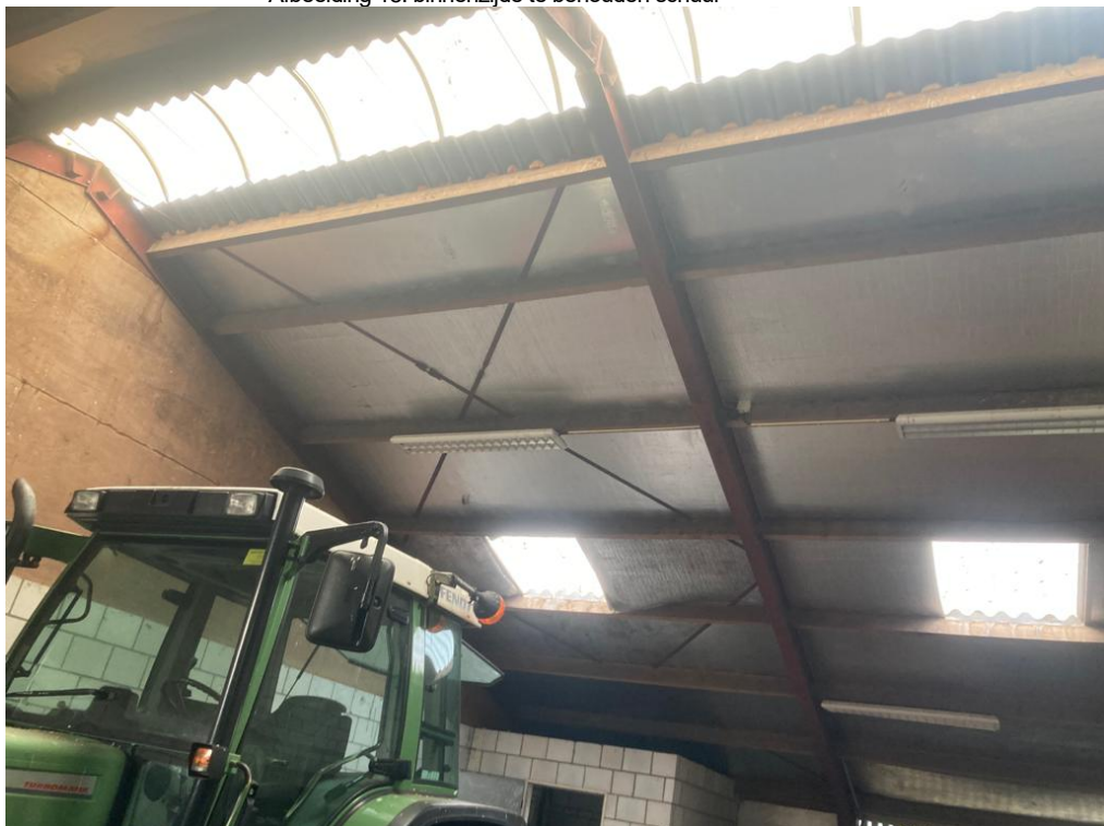
• Afbeelding 18: binnenzijde te behouden schuur
