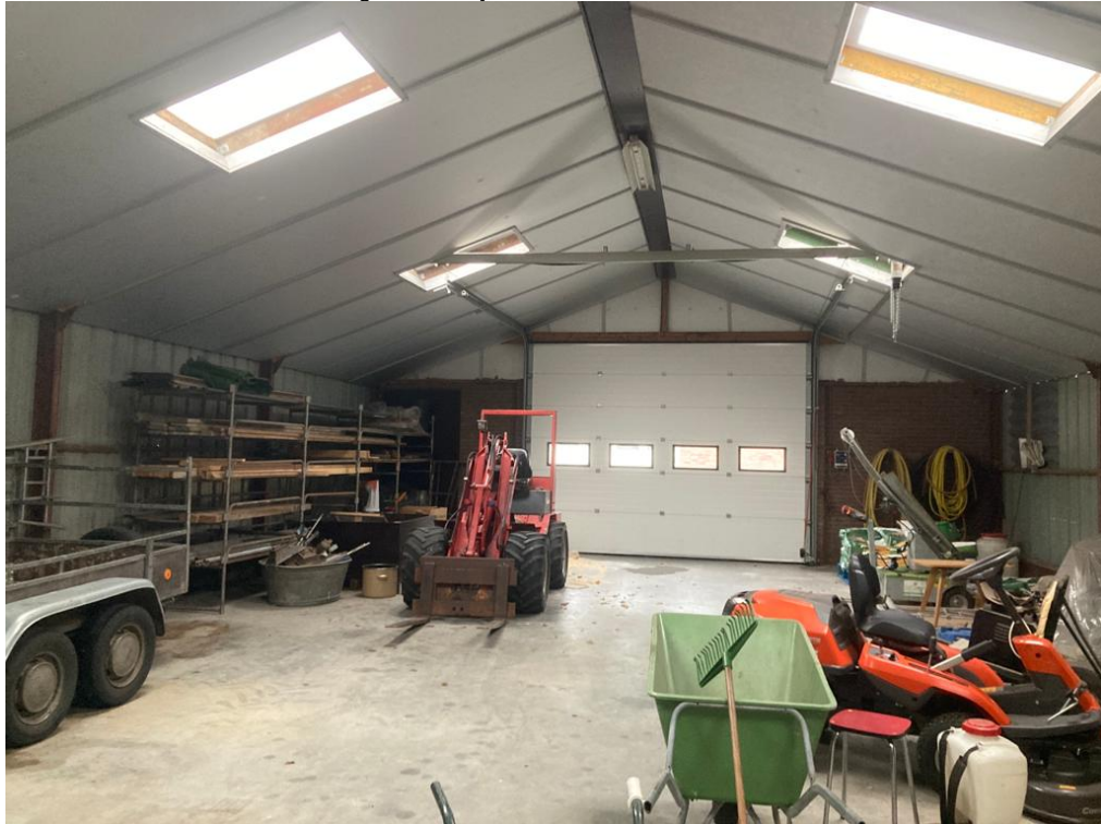
• Afbeelding 5: binnenzijde te behouden schuur
