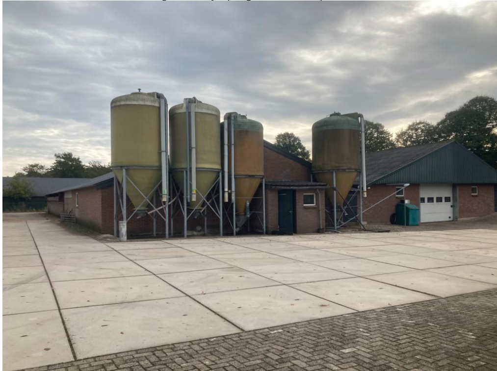
• Afbeelding 13: voorzijde plangebied met te slopen varkensstallen
