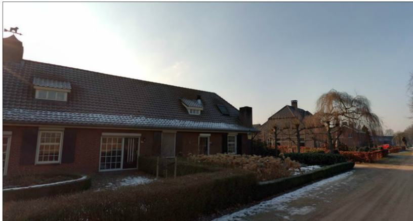
Afbeelding 19: de woningen Nieuwe Erven 31-37
