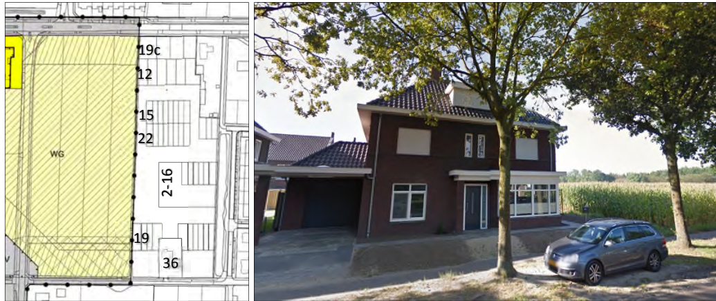
Afbeelding 12: de woningen nabij de nieuwe planologische situatie en de woning Bosschebaan 19c
