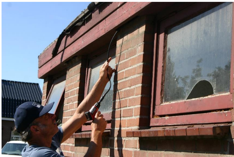
Figuur 4.4.7 Inspectie van de spouw aanbouw woning.
