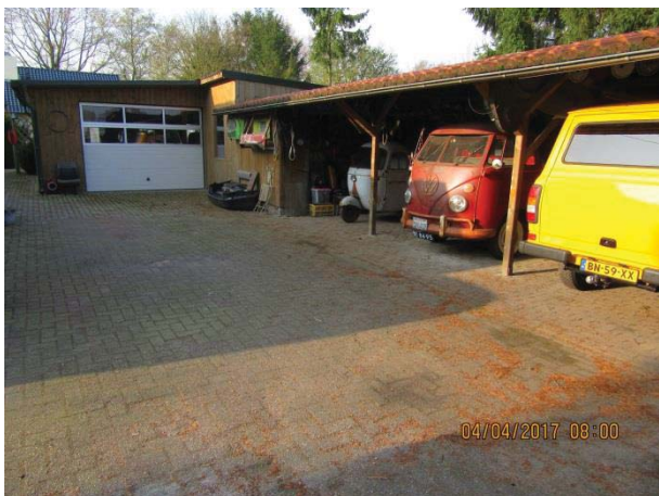
Foto 30 Bijgebouw C - overkapping
