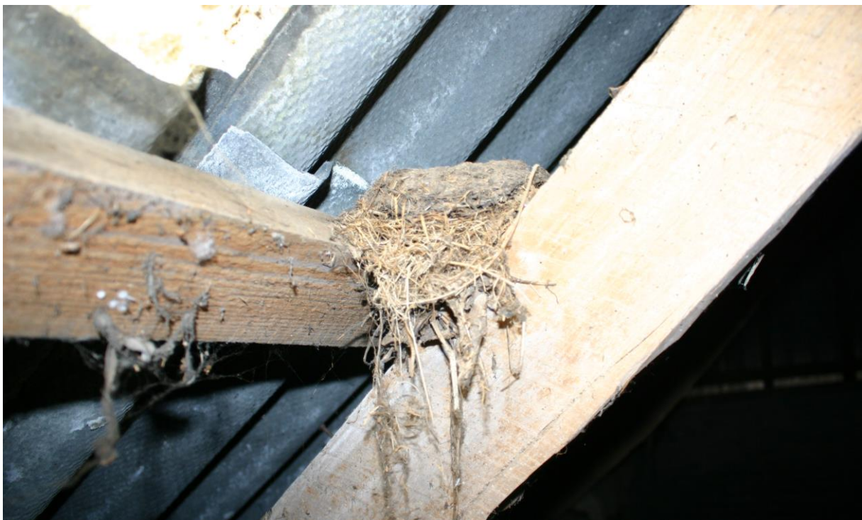
Figuur 4.5.1. Op een van de twee zolders bevindt zich een merelnest.
