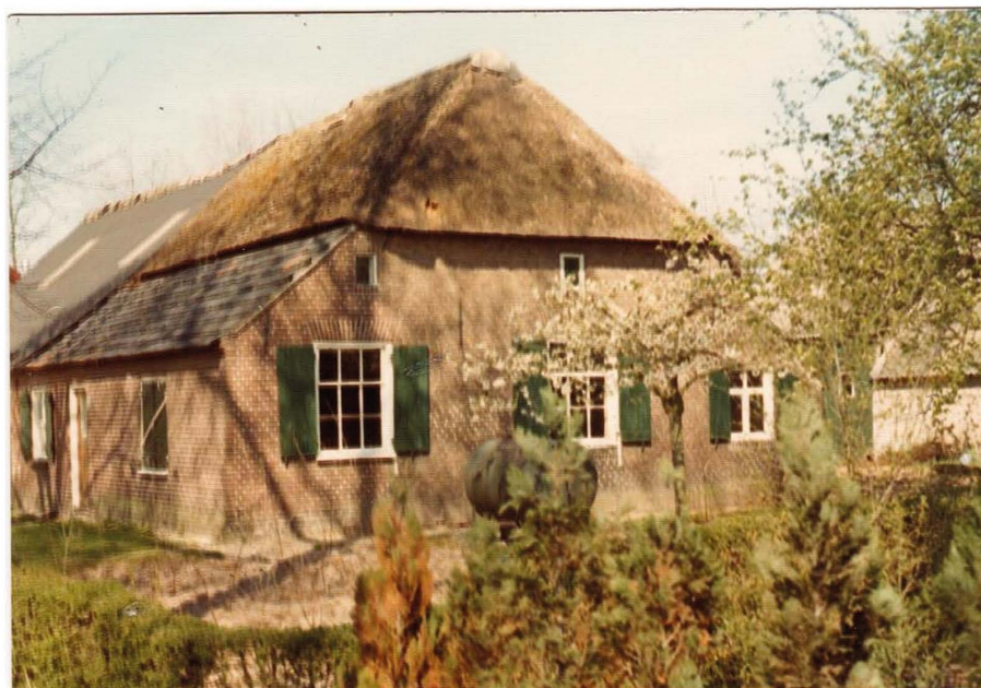
Ongedateerde foto van de boerderij Zoggelsestraat 88 naar het noordwesten gezien. Boven het bedrijfsgedeelte is het rieten dak reeds vervangen door golfplaten. Bron: fam. Van den Akker.
