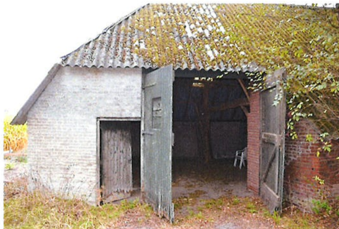
Linkerzijde van voorgevel met loopdeur en deeldeuren.
