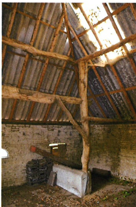
Links en rechts: eerste ankerbalkgebint met zicht op de sporenkap.
