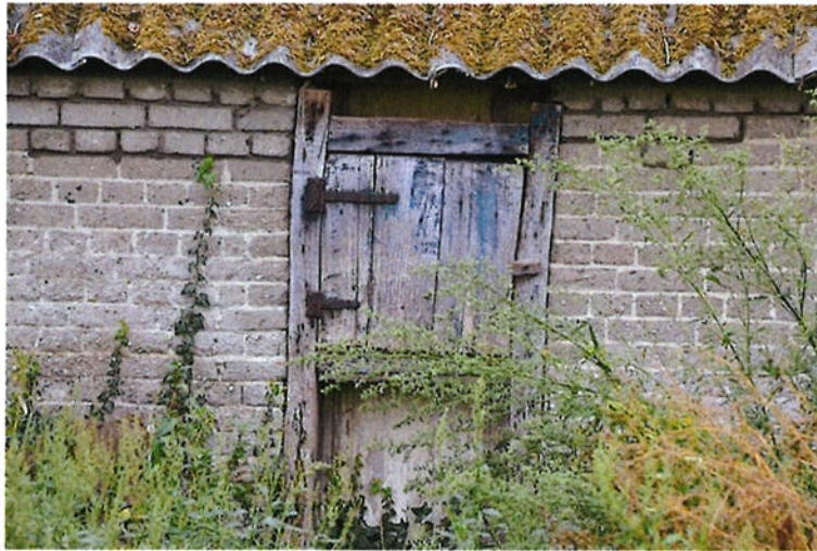
Detail achtergevel met de oudste houten deur.
