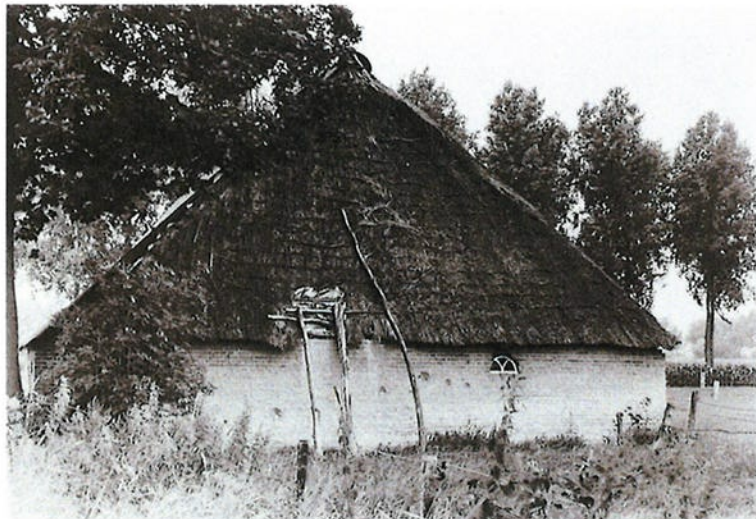
Oude foto van de schuur vanaf het oosten gezien, 1989. Op het dakschild ligt nog een dakbedekking van stro. Bron: BHIC.
