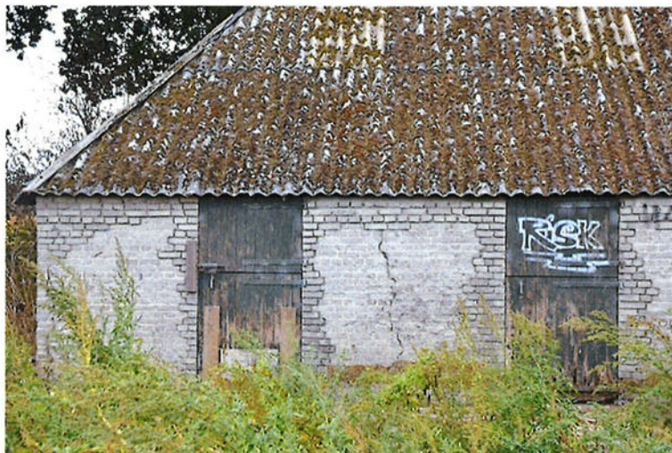
Detail achtergevel met de later geplaatste deuren.
