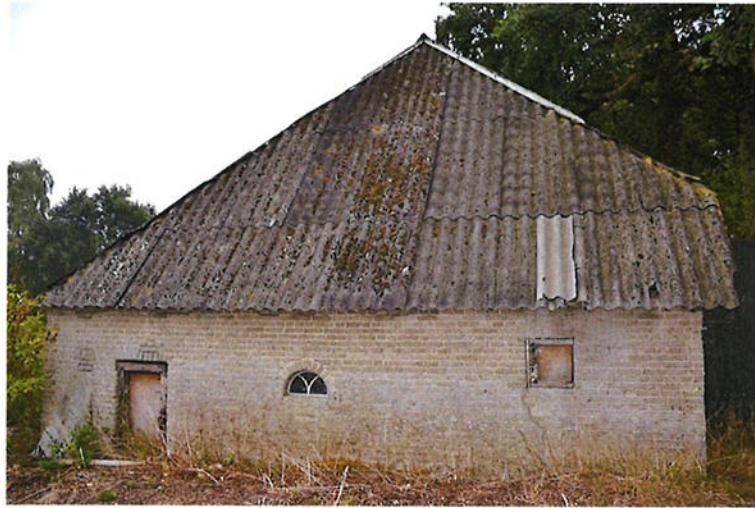
Zijgevel vanuit het westen gezien.
