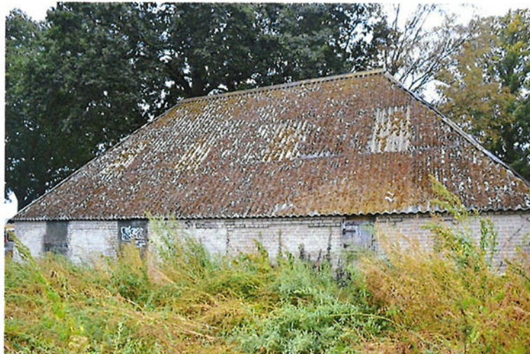
Achtergevel vanuit het noorden gezien.
