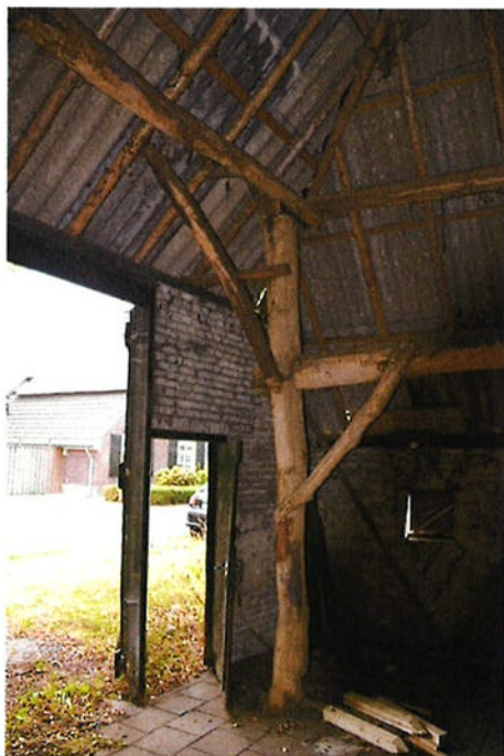
Links en rechts: eerste ankerbalkgebint met zicht op de sporenkap.
