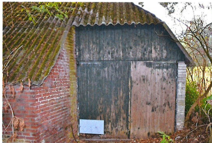
Houten dubbele deuren rechts in de voorgevel.
