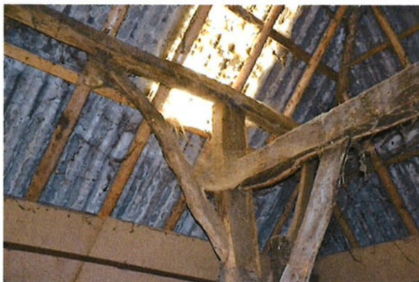
Links en rechts: het derde ankerbalkgebint
