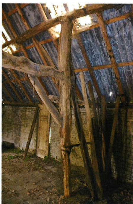
Links en rechts: het tweede ankerbalkgebint. De gebintstijl aan de voorzijde is ingekort vanwege het nieuwe metselwerk.
