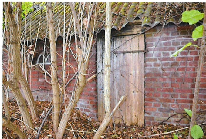
Aanbouw met loopdeur en stalvenster.
