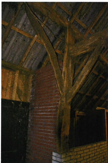
Links en rechts: het derde ankerbalkgebint
