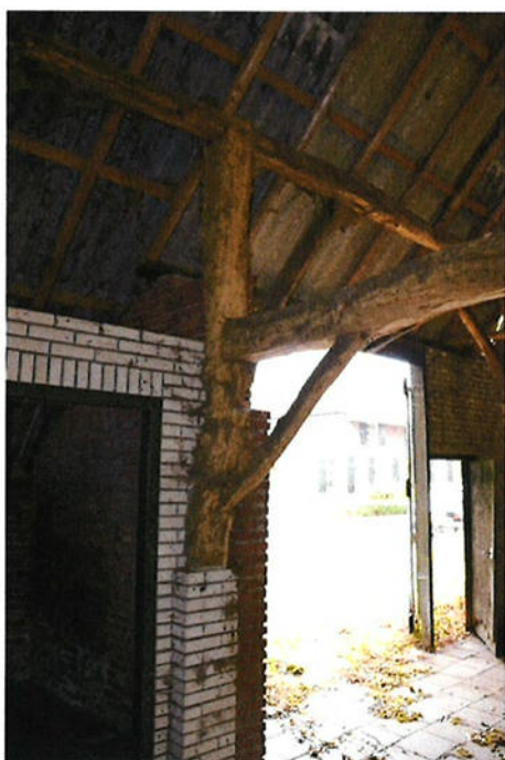
Links en rechts: het tweede ankerbalkgebint. De gebintstijl aan de voorzijde is ingekort vanwege het nieuwe metselwerk.
