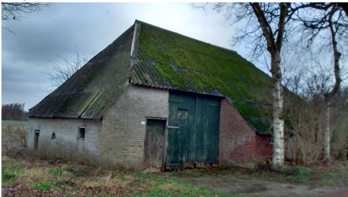
Zuidzijde van de oude schuur vanuit het zuidwesten:
