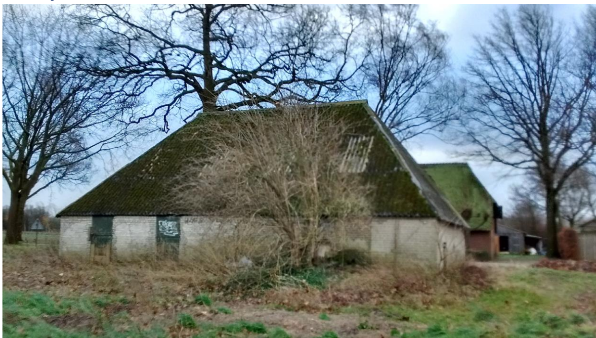
Noordzijde van de oude schuur vanuit het noorden:
