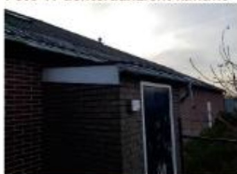
Foto 19 kleine aanbouw kantine
