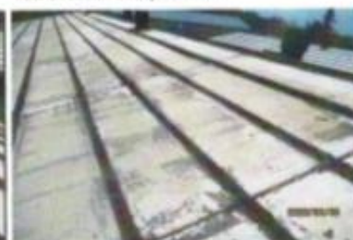
Foto 11 : Balken en dupanel stal 2
