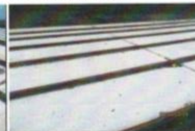
Foto 12 : Balken en dupanel stal 2
