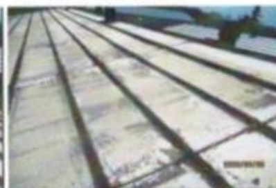
Foto 8 : Balken en dupanel stal 1
