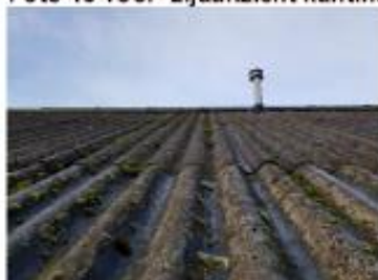
Foto 18 dak met nok kantine
