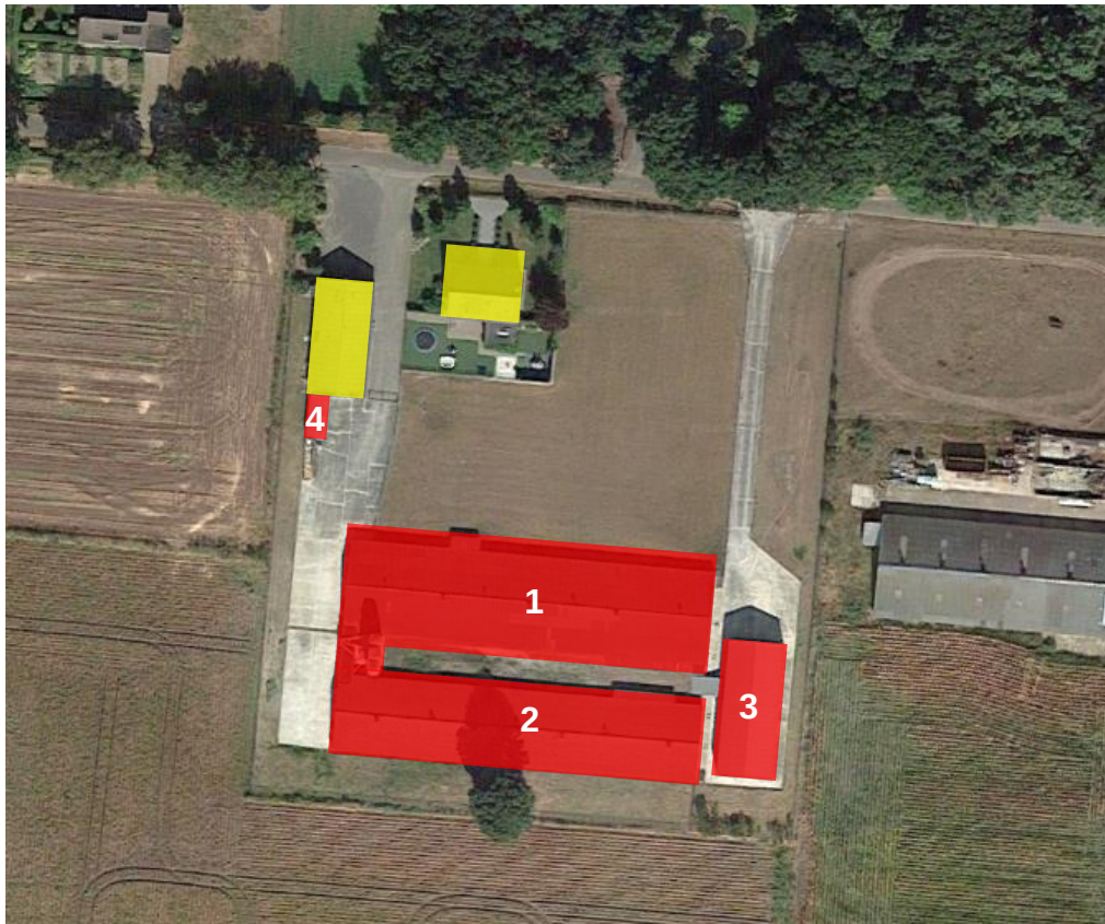
Figuur 1 Slooplocatie met de te slopen bebouwing rood gearceerd
