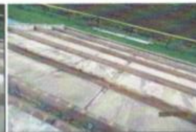
Foto 6 : Balken en dupanel kantine
