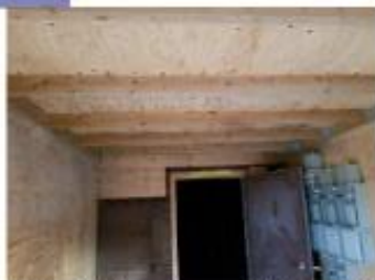
Foto 12 binnen aanzicht plat dak tussenbouw
