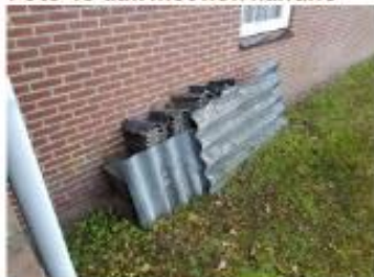
Foto 20 losse platen langs kantine
