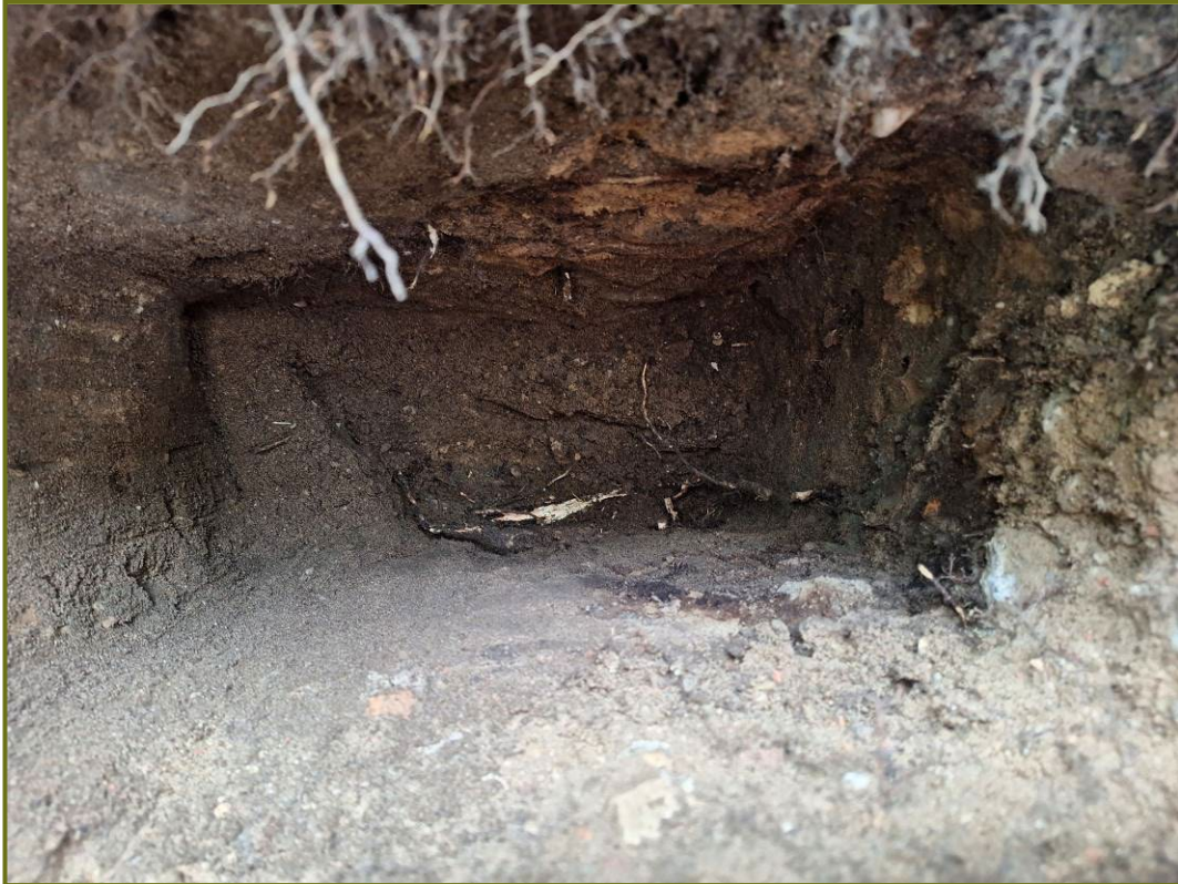
Afbeelding 11. Wortels groeiend in de lengterichting van de berm, beperkt richting rijbaan
