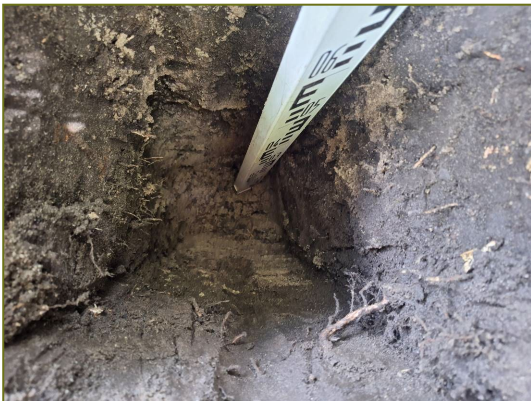
Afbeelding 14. Dieper in de sloot nog geen grondwater, wel vochtig tot natte grond
