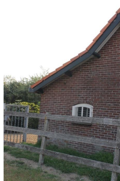
Vernieuwde stelvensters in bestaande sparing
