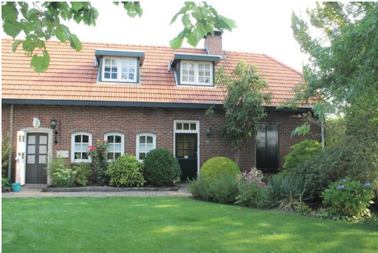
Woongedeelte met vernieuwde deur en venster in bestaande sparing
