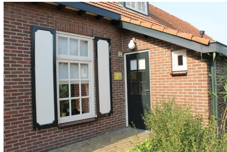
De achterom en toiletvenster in verbrede gedeelte
