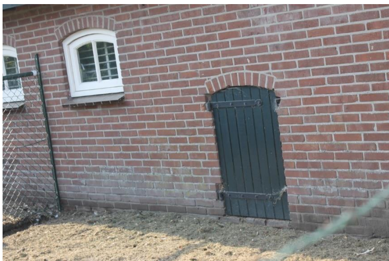
Vernieuwd houten stalvenster en varkensdeur
