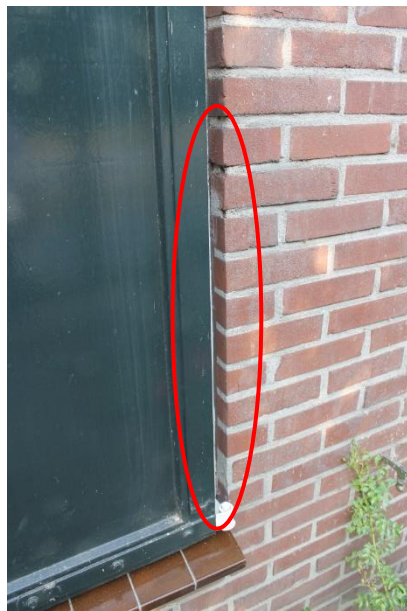
Ingezaagde dagkant metselwerk
