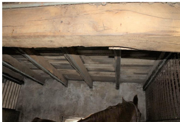
Zware balk en houten verdiepingsvloer uit de bouwtijd
