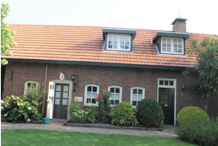
Vernieuwde stalvensters in bestaande sparingen
