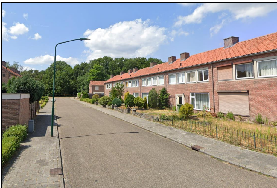
Huidige situatie Leonardus van Veghelstraat met de te slopen bebouwing (bron: Google Maps).
