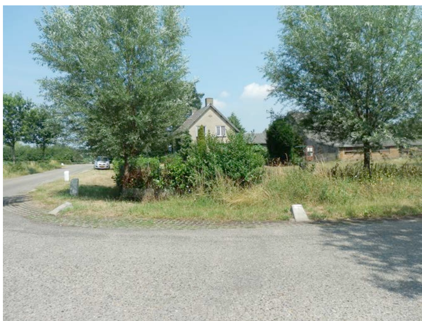
Plangebied te slopen bedrijfswoning gezien in S-bocht vanaf Vosbergstraat
