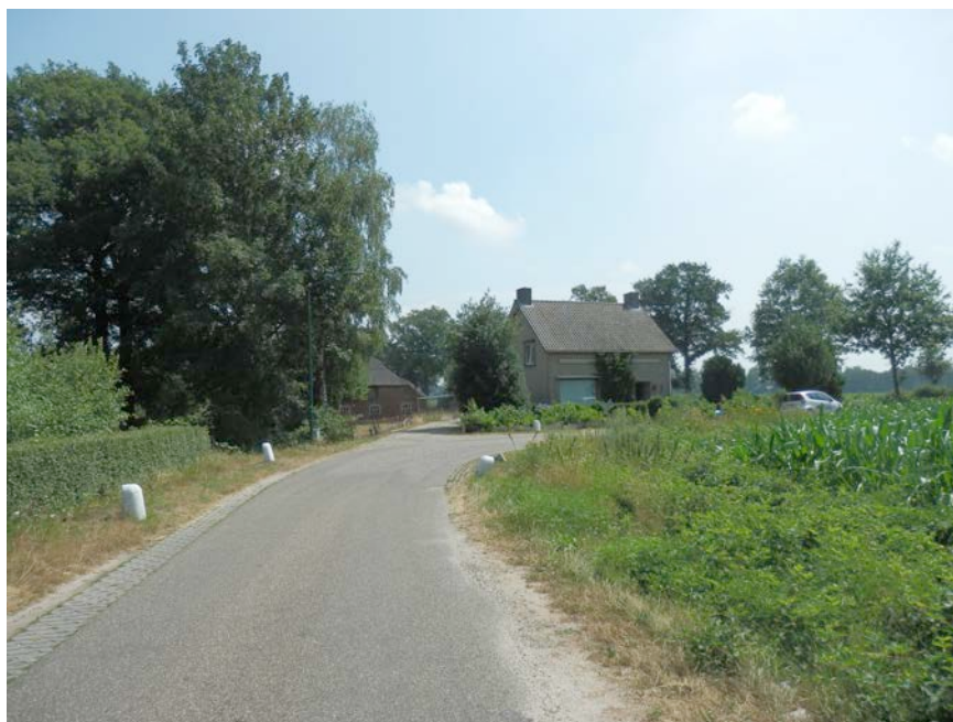
Plangebied te slopen bedrijfswoning gezien voor S-bocht vanaf Vosbergstraat
