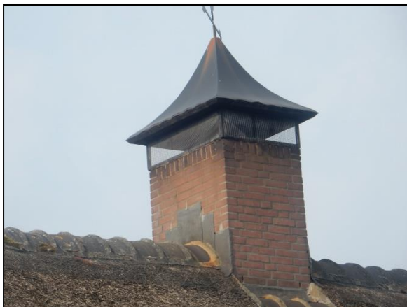
Figuur 9. Afgeschermd schoorsteen.
