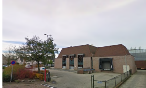
Entree parkeerterrein van Den Hof
