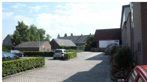
Parkeerterrein Van Tilburg zicht op boerderij en erf
