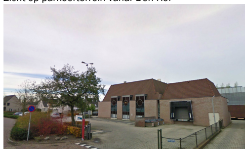
Entree parkeerterrein van Den Hof
