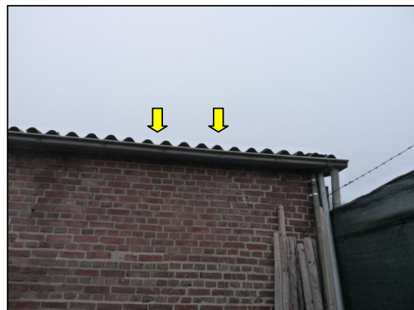
Figuur 10. Ruimtes tussen het dak en de dakgoot bieden potentieel geschikte ruimtes voor de huismus.
