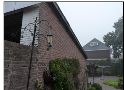
Figuur 5. Zijkant onderzoekslocatie.
